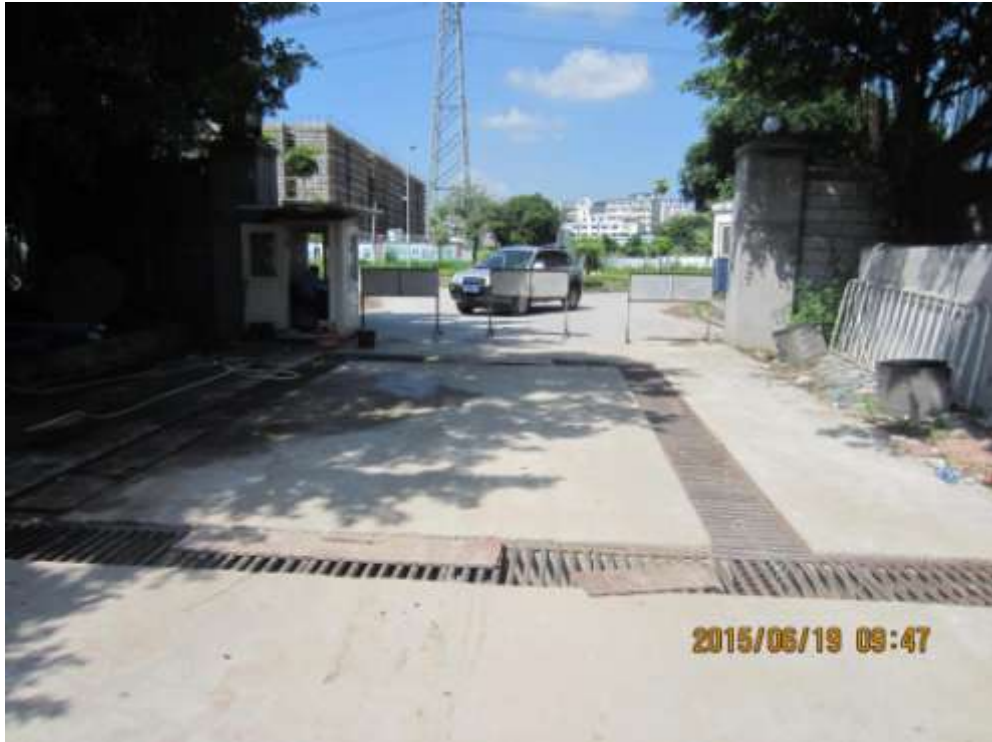
图3 施工出入口洗车台
