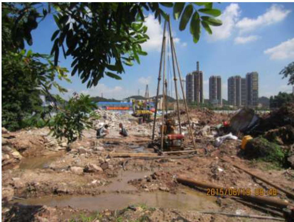
图 1 项目区北部试桩施工现状
