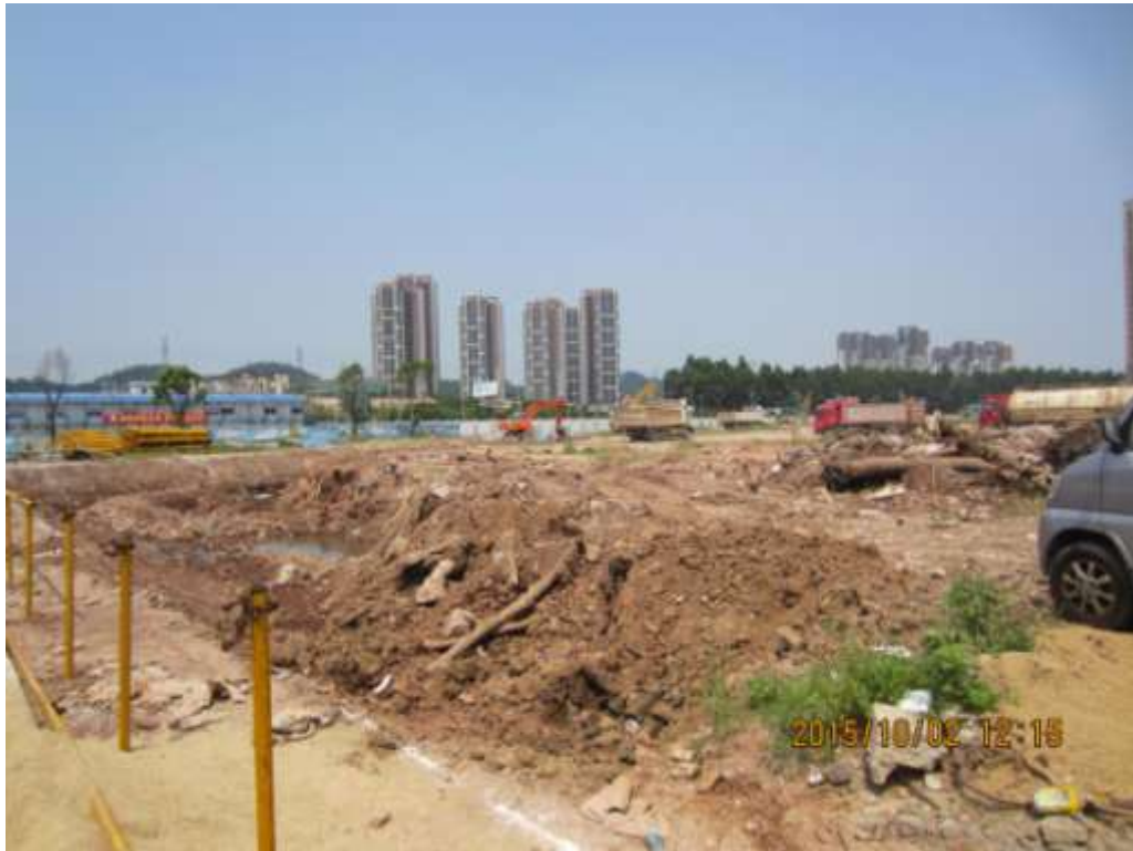
图 5 项目区北部施工现状
