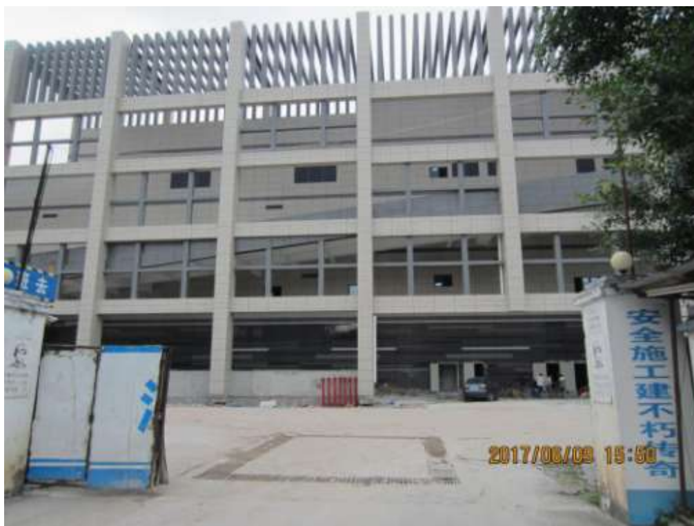
图 15 建筑框架施工完毕
