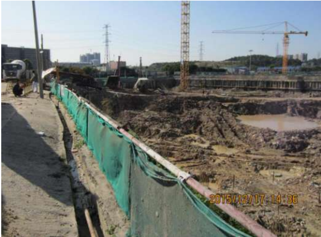
图 7 基坑施工现状
