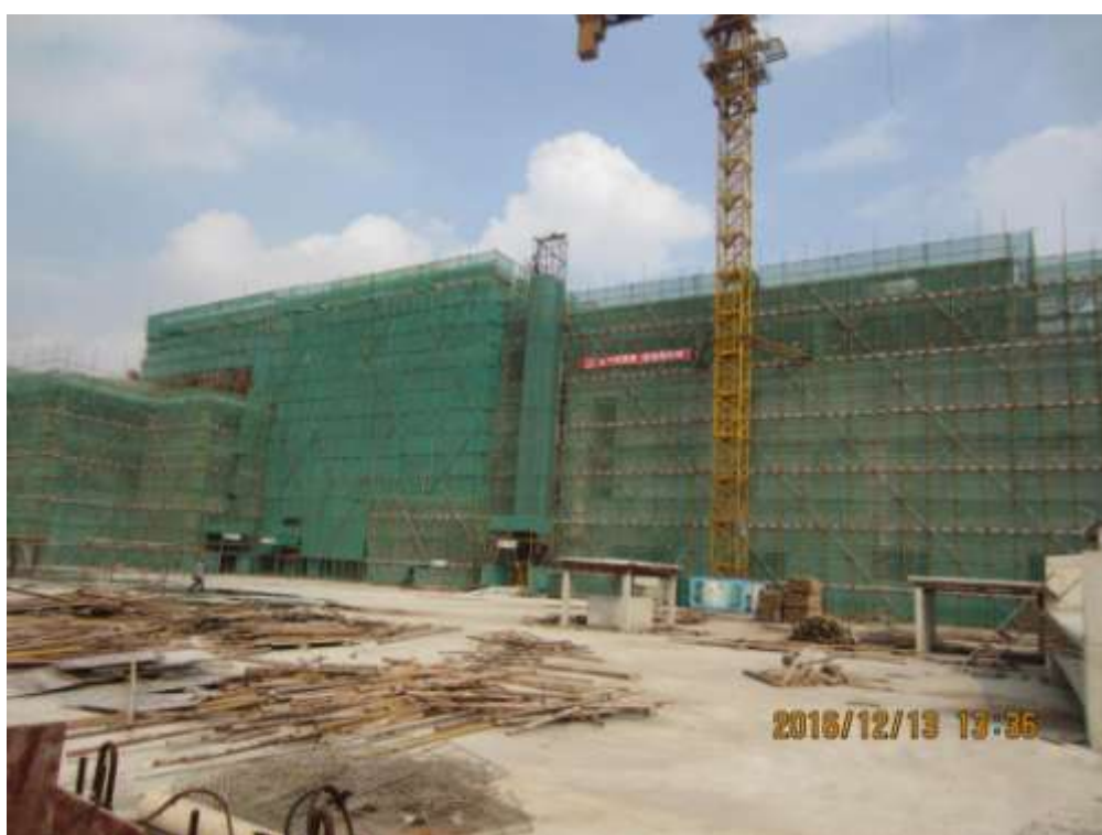
图 14 建筑物框架施工
