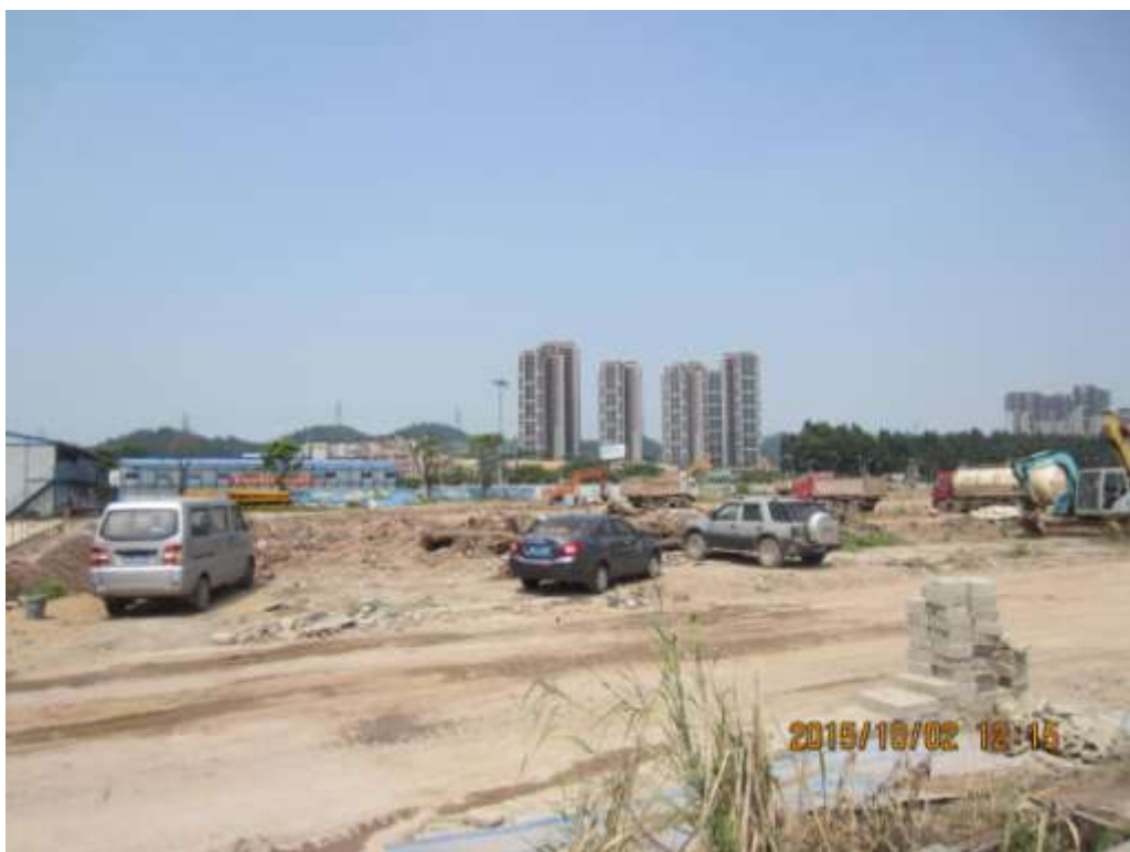
图 6 项目区北部施工现状
