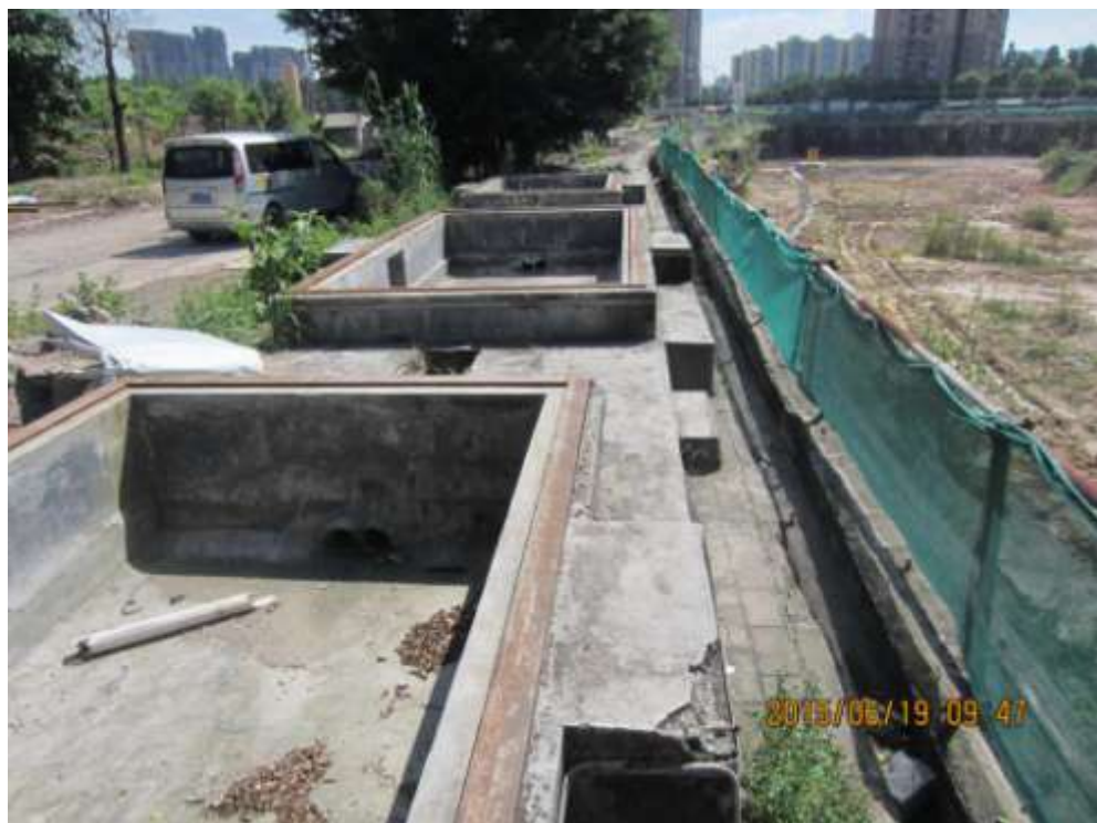
图4 南部基坑截水沟
