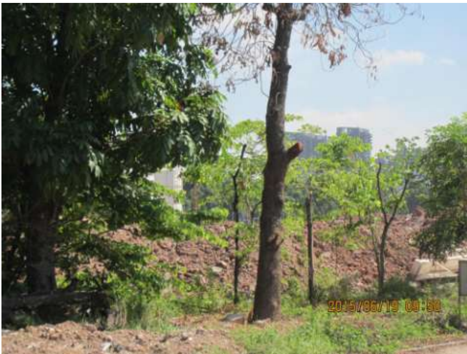
图 2 项目区北部试桩施工现状
