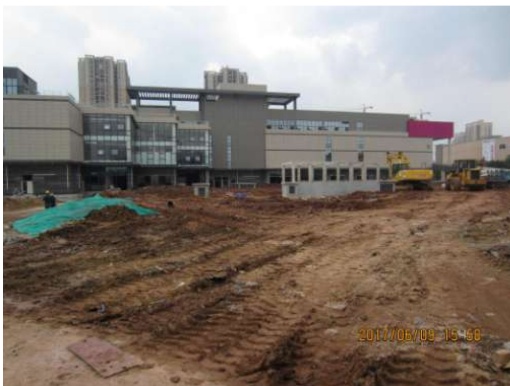
图 16 建筑框架施工完毕
