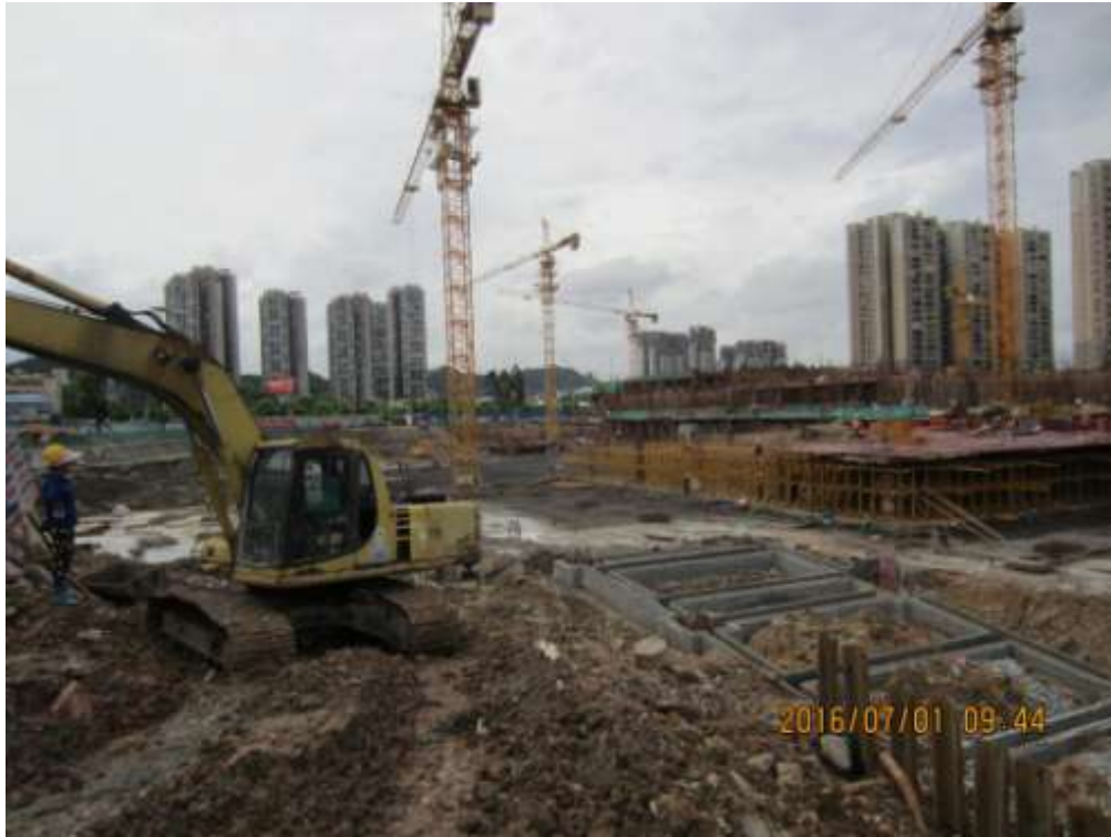
图 9 基坑施工现状
