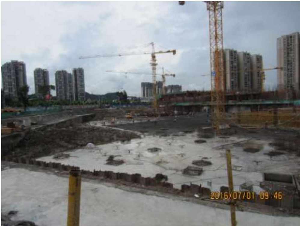
图 10 基坑施工现状
