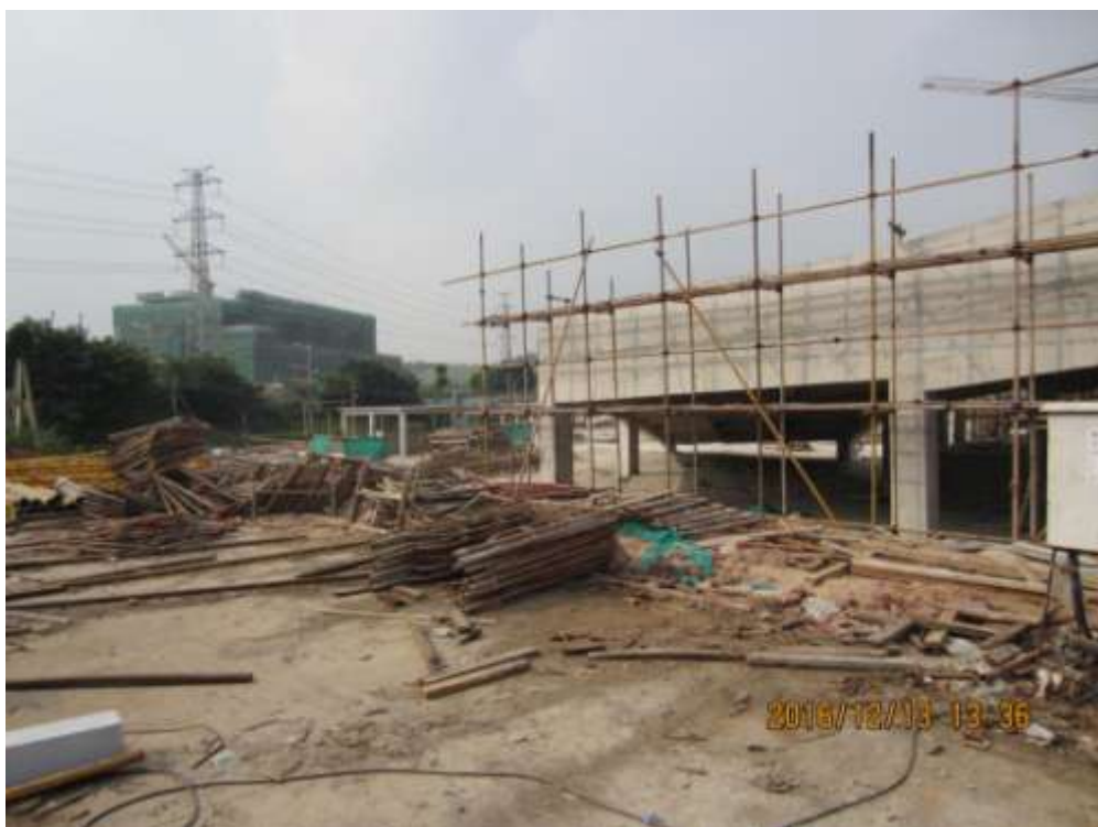
图 13 建筑物框架施工
