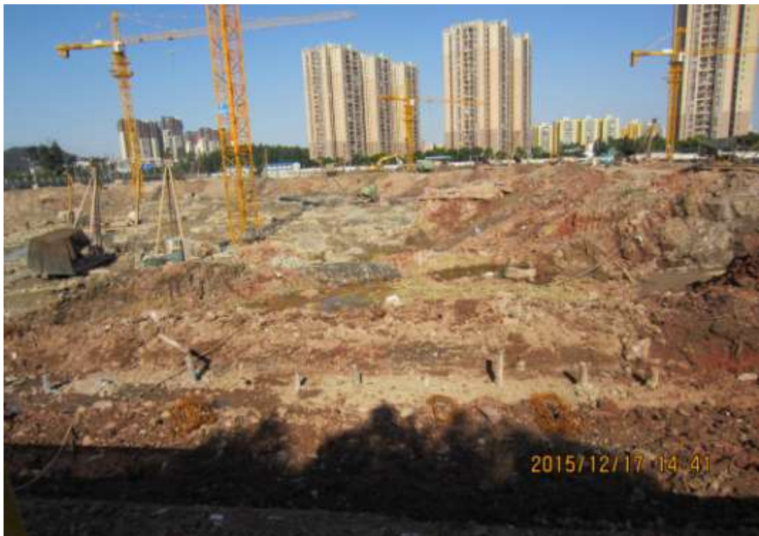
图 8 基坑施工现状
