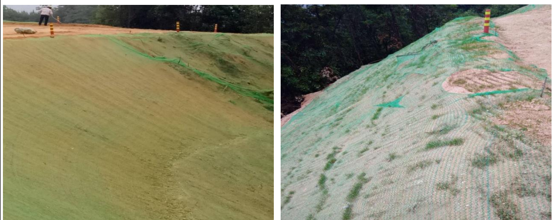
开挖过程中临时覆盖
