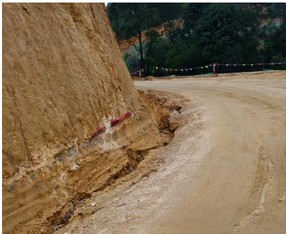
施工（检修）道路施工排水尚未完善
