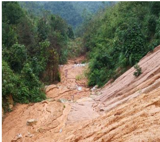
施工（检修）道路施工排水尚未完善
