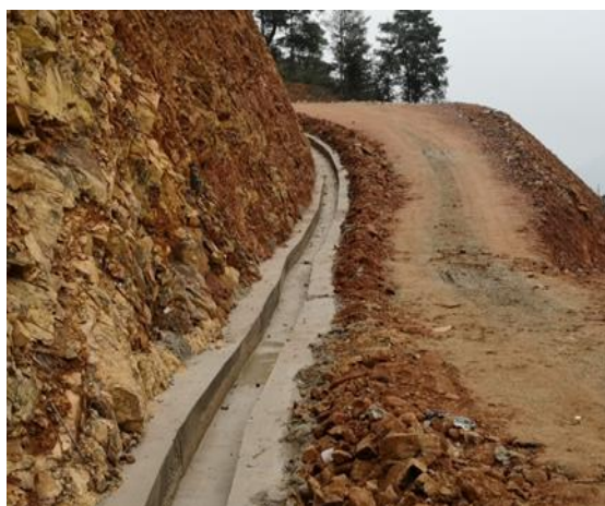
施工（检修）道路排水沟施工
