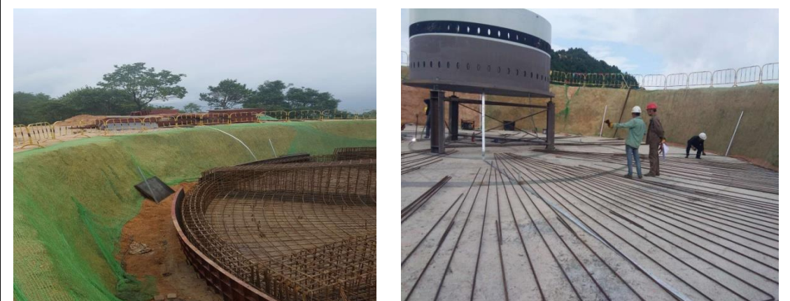
风机基础平台施工
