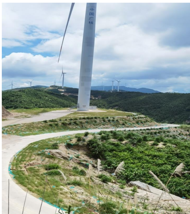
风机基础平台及道路边坡绿化
