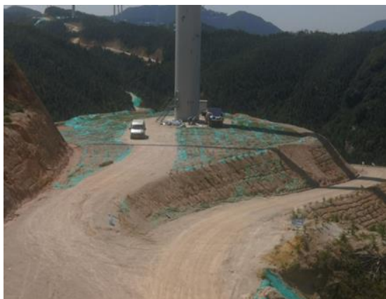
风机平台施工
