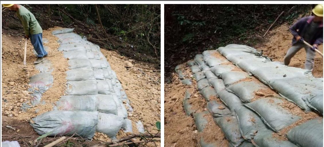
临时拦挡施工
