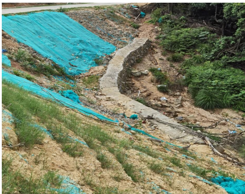
路侧挡墙及边坡绿化
