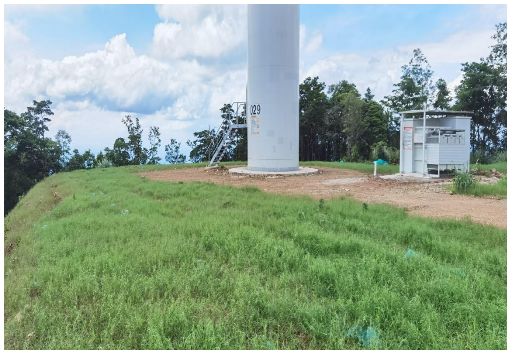
风电机组区风机基础平台
