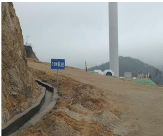
施工（检修）道路排水沟施工
