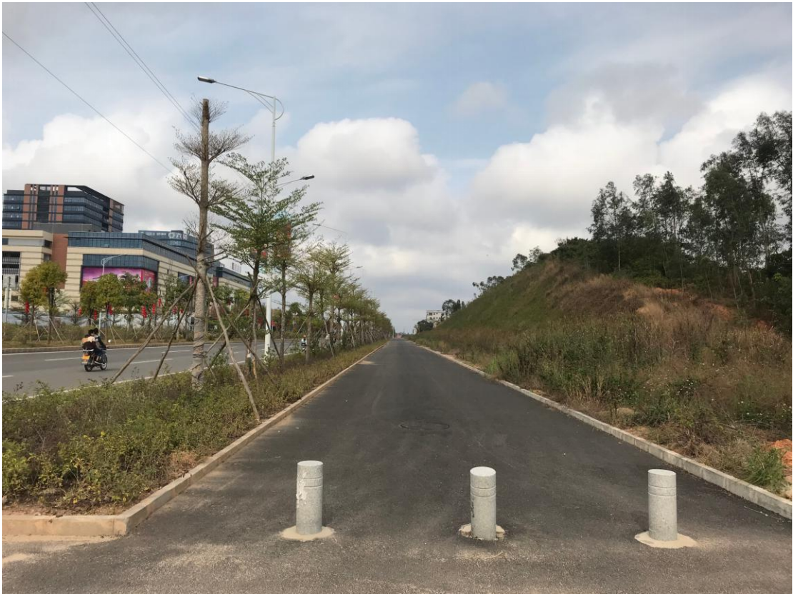
桩号 K2+720 段道路右侧开挖边坡
