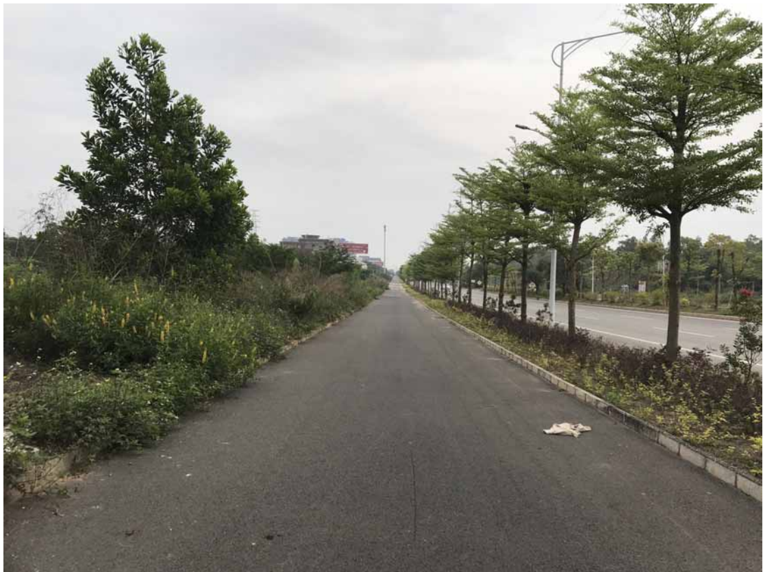
桩号 K2+880 左侧边坡
