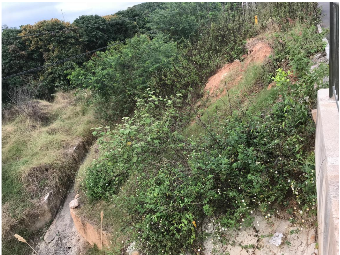
桩号 K2+200 左侧回填边坡
