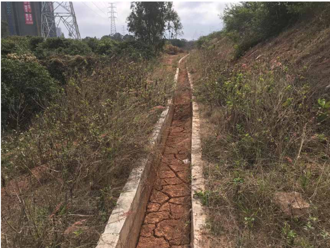
桩号 K1+920 段道路右侧回填边坡
