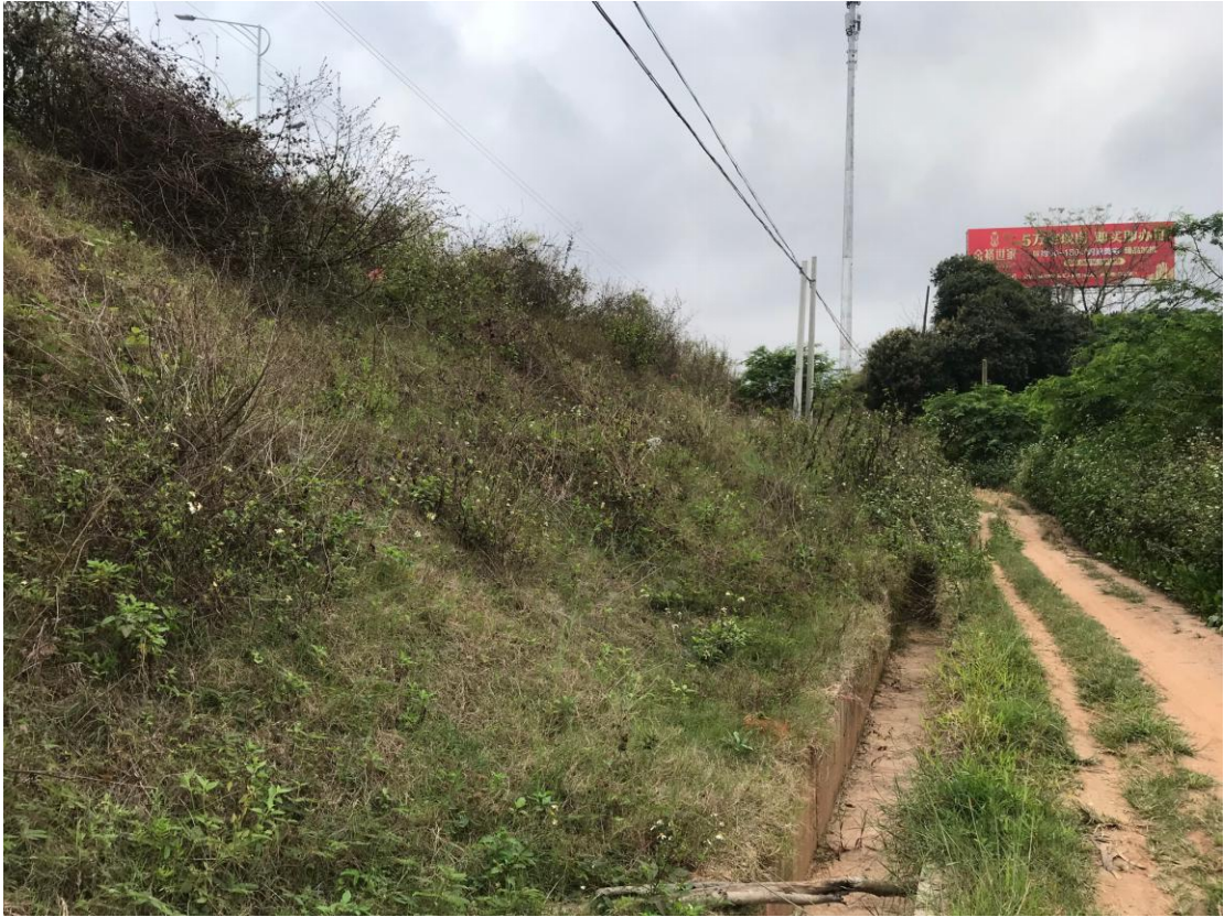
桩号 K2+560 左侧回填边坡
