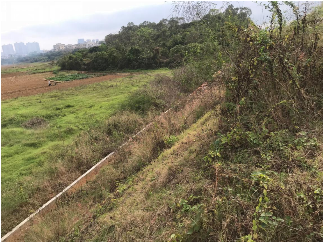
桩号 K2+900 段道路右侧回填边坡
