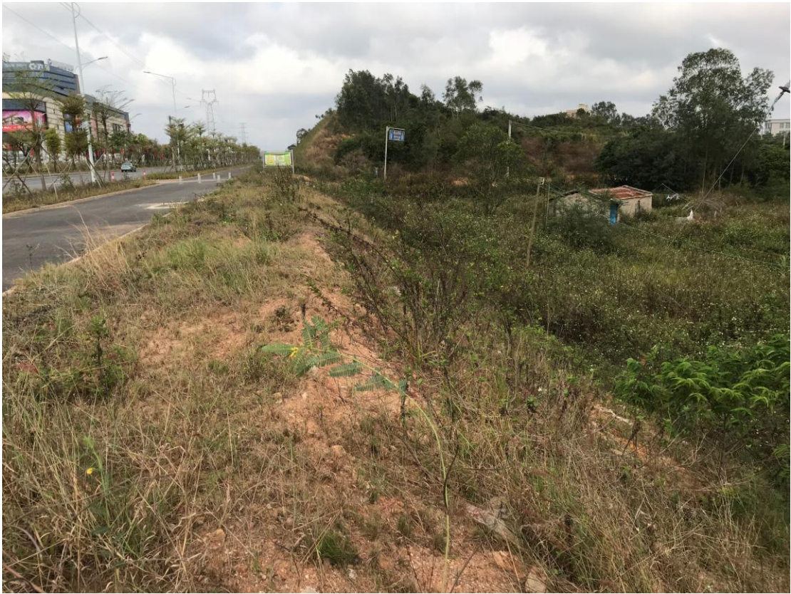
桩号 K2+680 段道路右侧回填边坡
