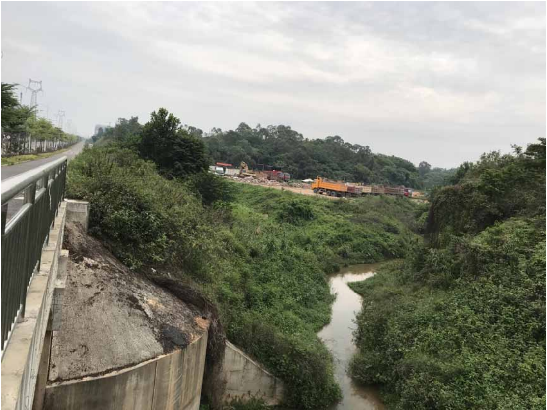
桩号 K2+200 右侧回填边坡
