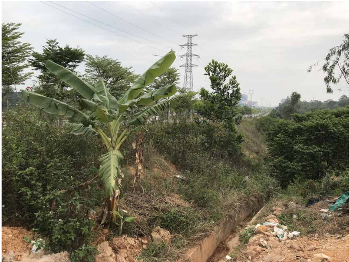
桩号 K2+100 段道路右侧回填边坡
