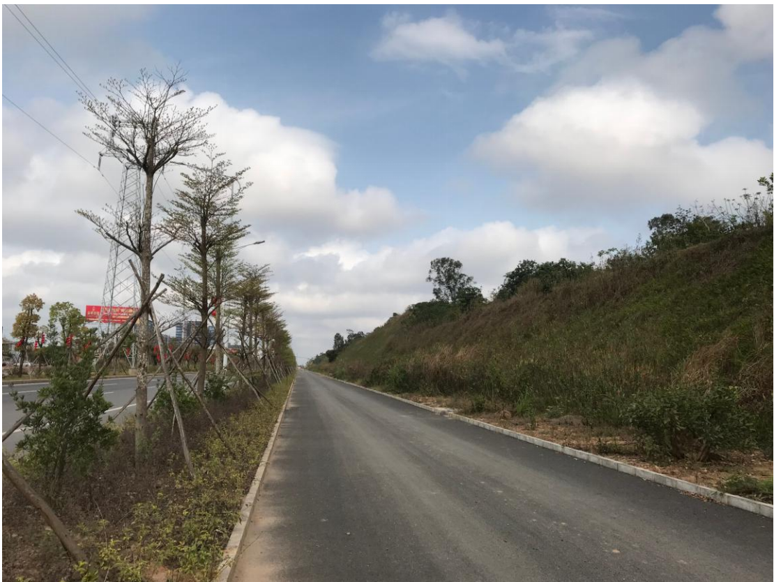
桩号 K2+560 段道路右侧开挖边坡
