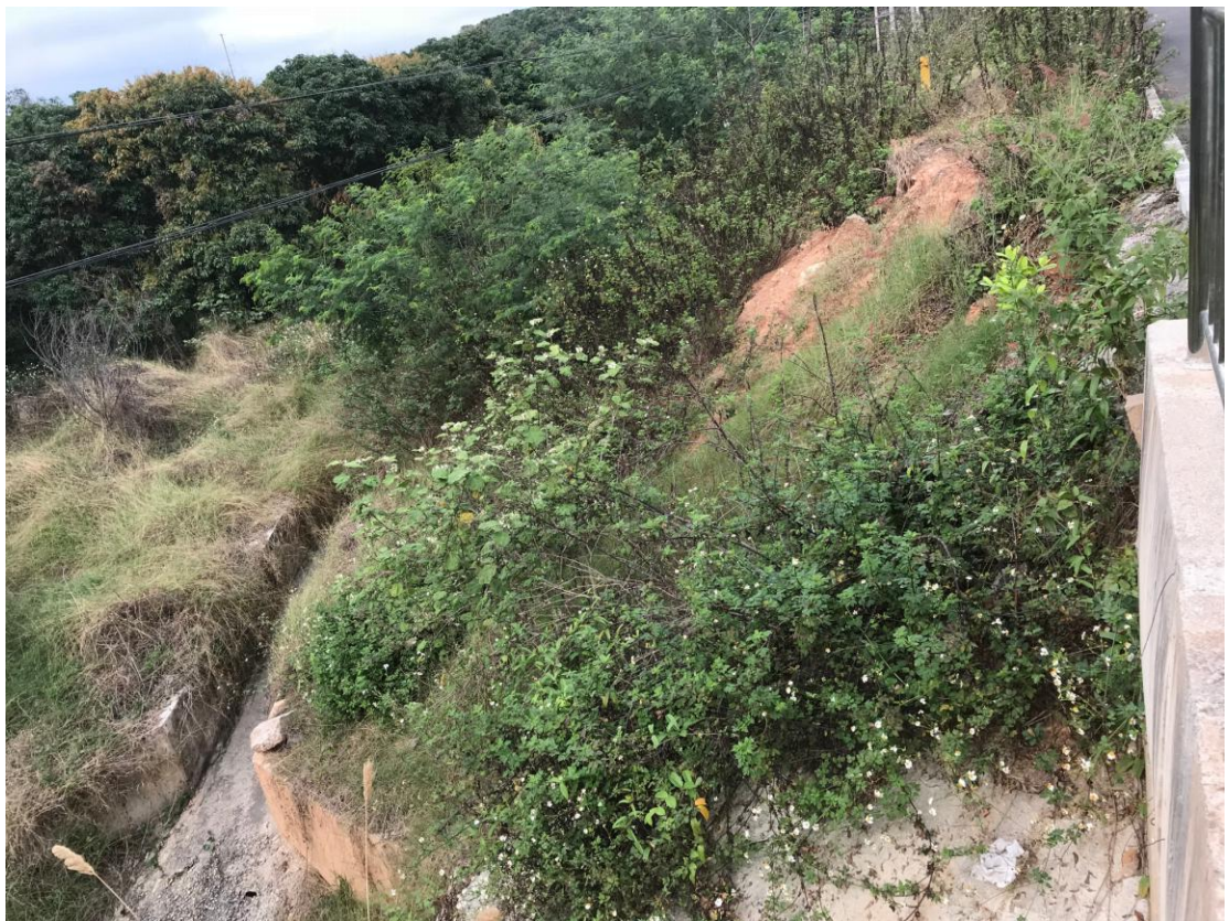
桩号K2+200左侧回填边坡
