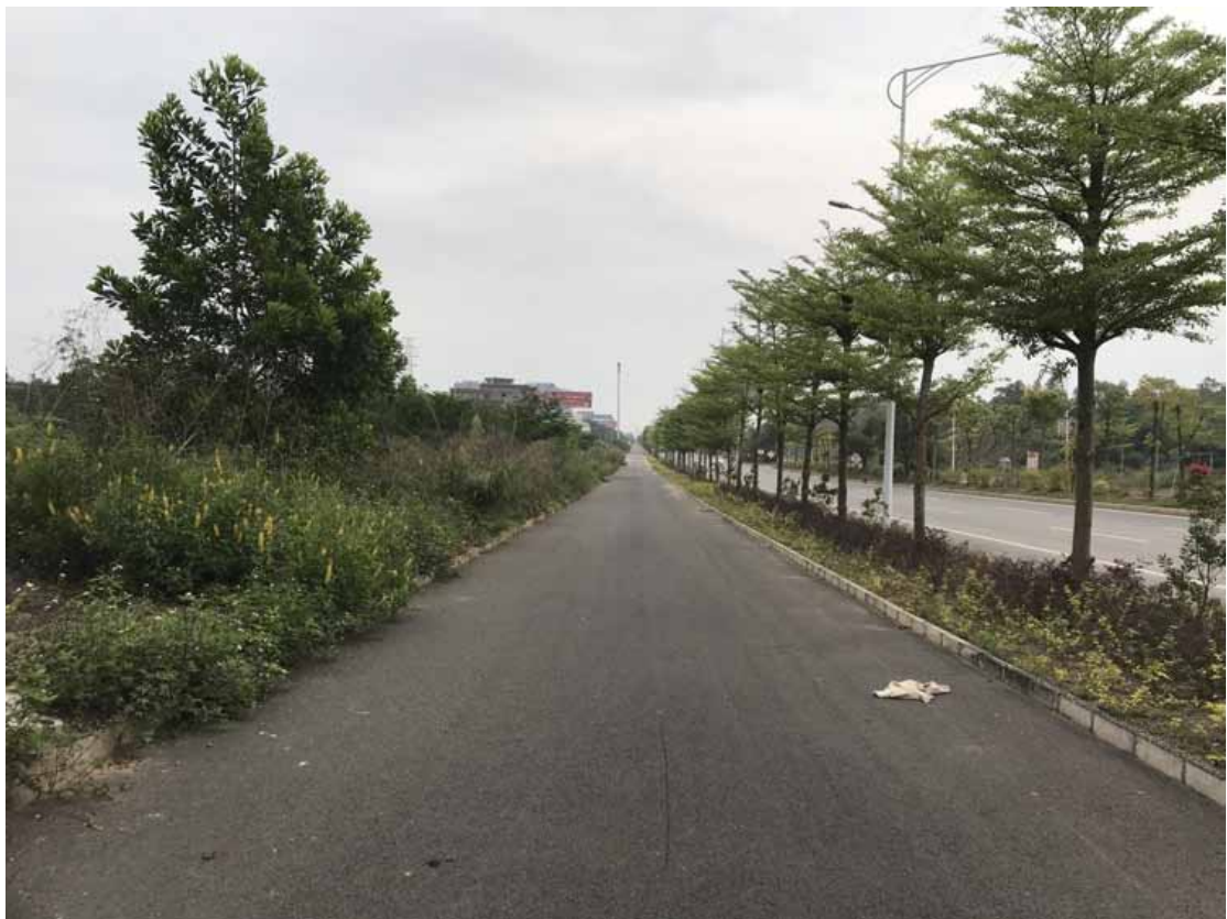
桩号K2+880左侧边坡
