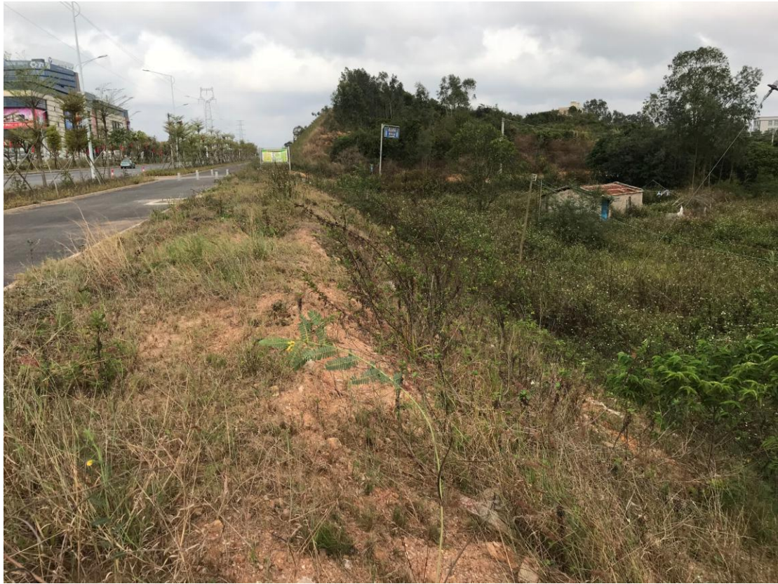
桩号K2+680段道路右侧回填边坡
