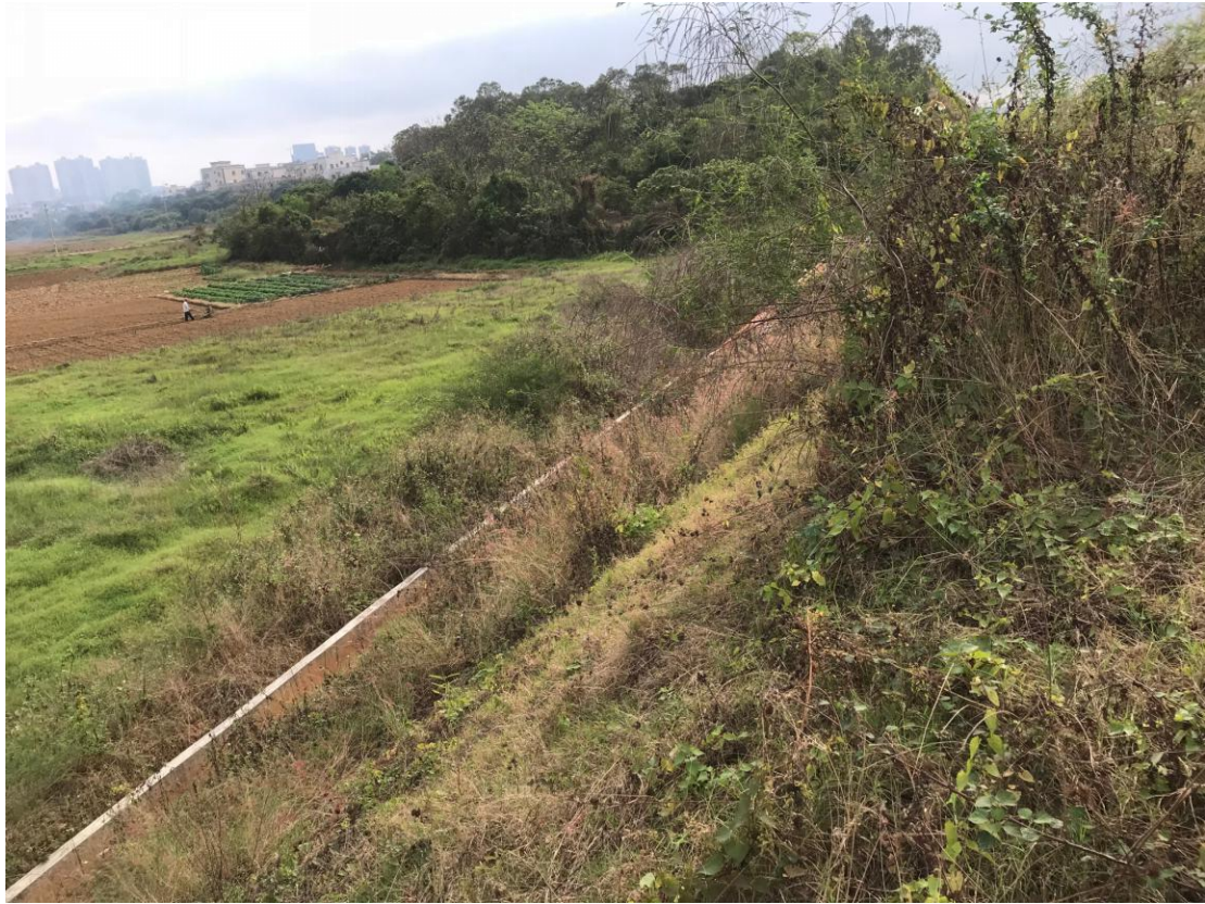
桩号K2+900段道路右侧回填边坡
