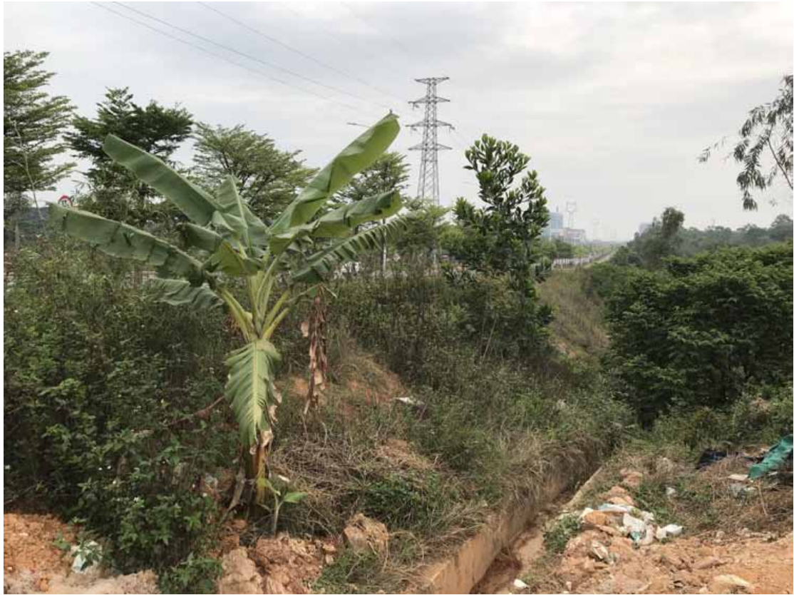
桩号K2+100段道路右侧回填边坡
