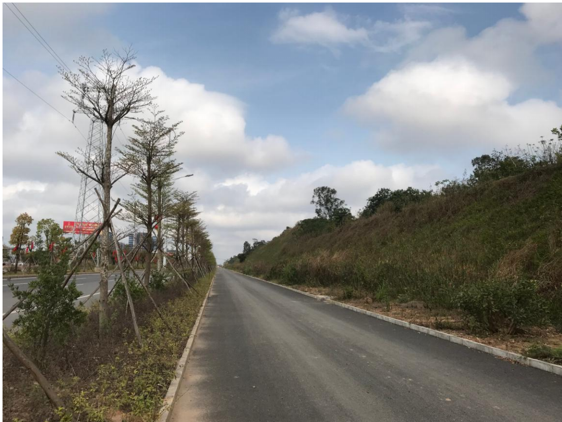
桩号K2+560段道路右侧开挖边坡
