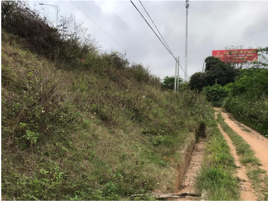
桩号K2+560左侧回填边坡
