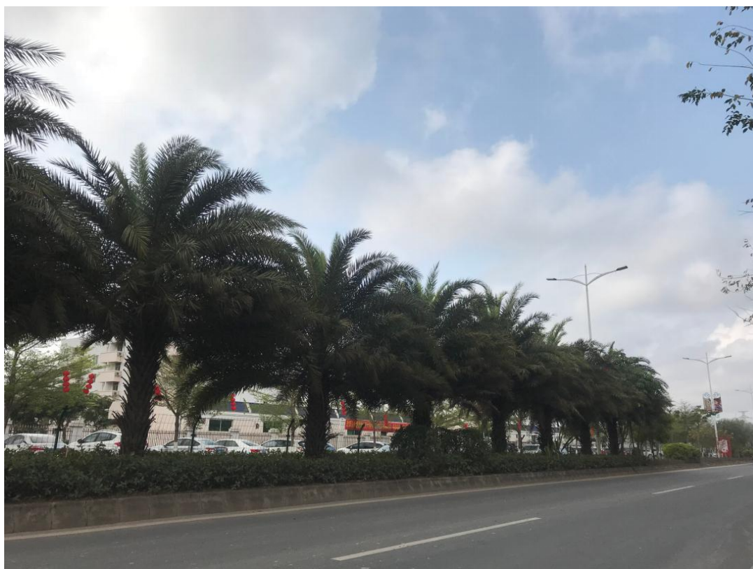
桩号K0+740段道路中间绿化
