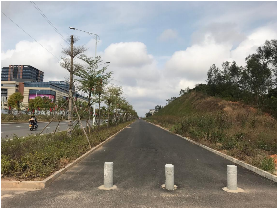
桩号K2+720段道路右侧开挖边坡
