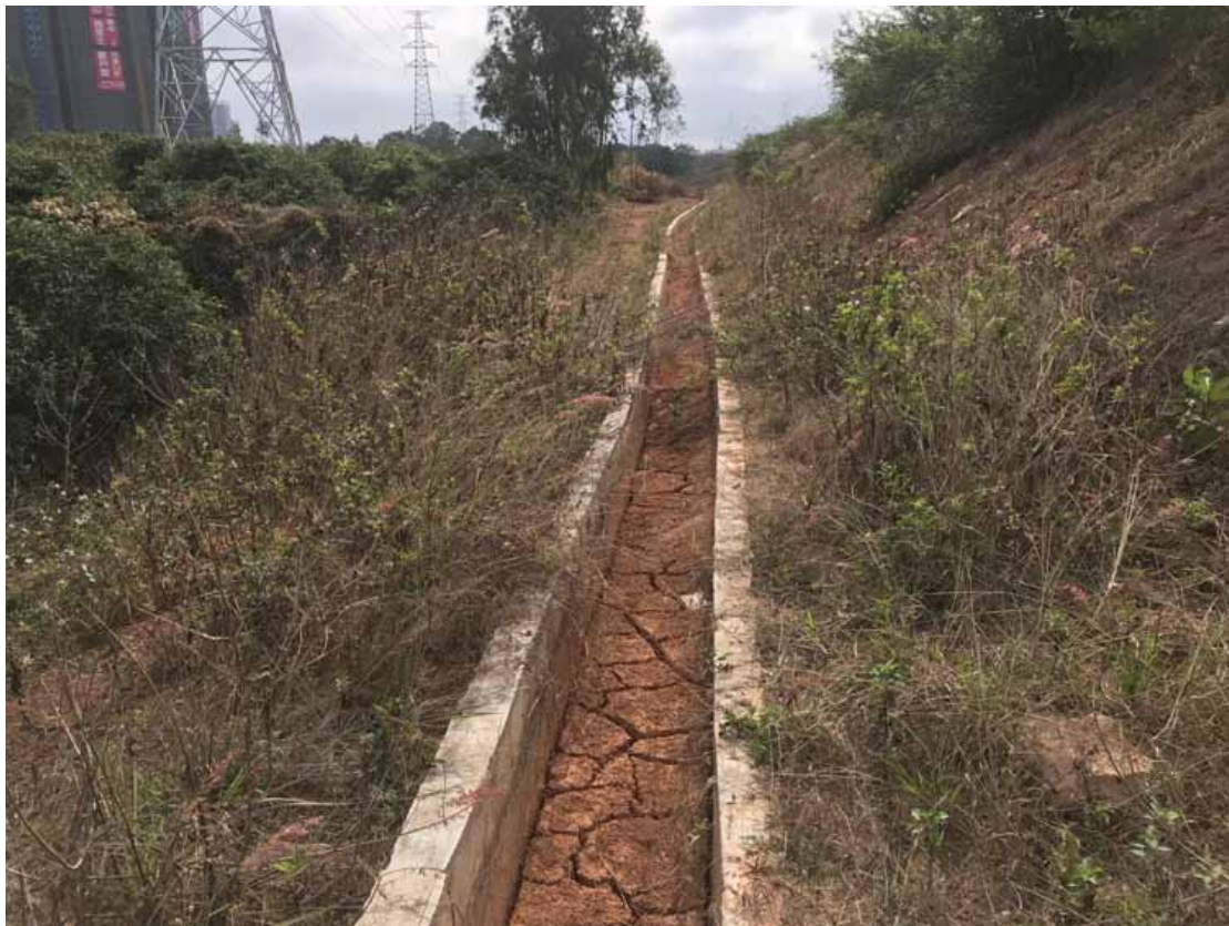
桩号K1+920段道路右侧回填边坡
