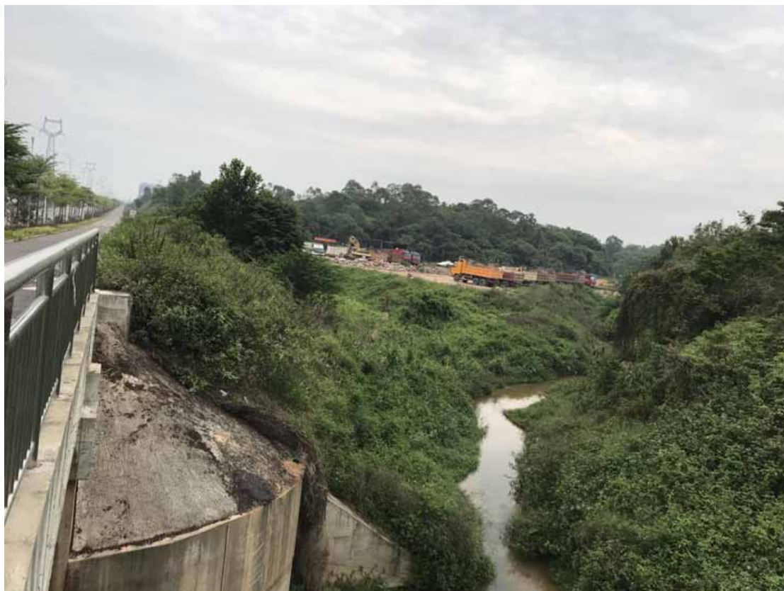
桩号K2+200右侧回填边坡
